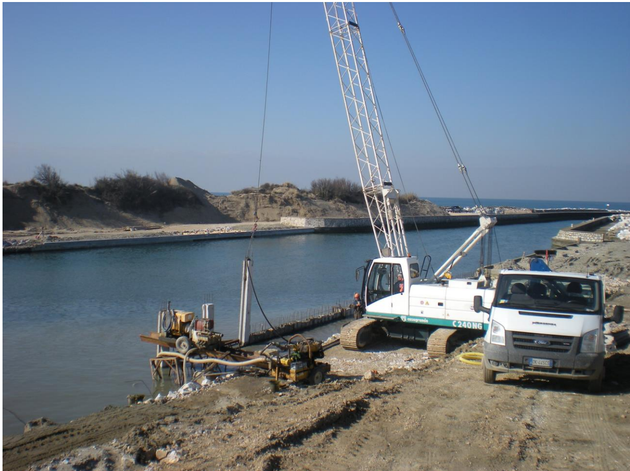
Fig.1.1 – infissione di palancole in cav
