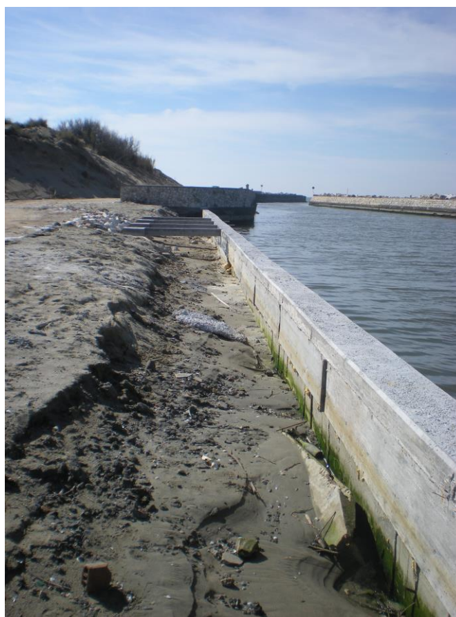
Fig.1.3 – paratia palancole in cav dopo il getto di completamento
