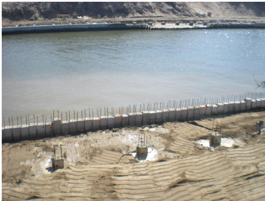
Fig.1.2 – paratia di palancole in cav dopo l'infissione
