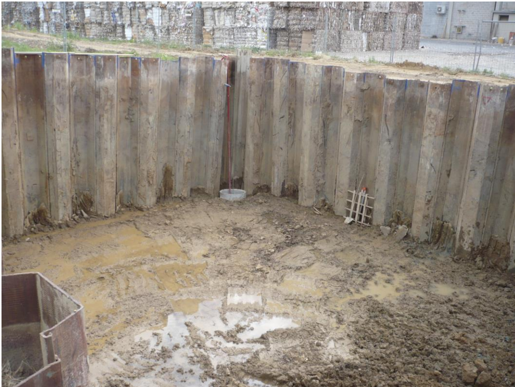
Fig.1.1 – Esempio di palanco lato metallico
