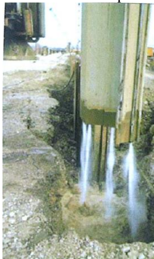
Fig.3.1 – Infissione di palancole ad acqua
