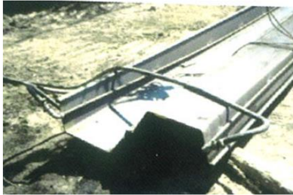
Fig.3.3 – Esempio di palancola con la predisposizione del circuito per il passaggio dell'acqua.
