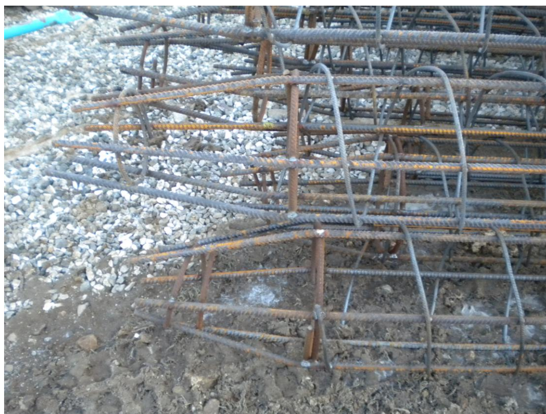
Fig.4.2b – Gabbie in cantiere pronte per la posa
