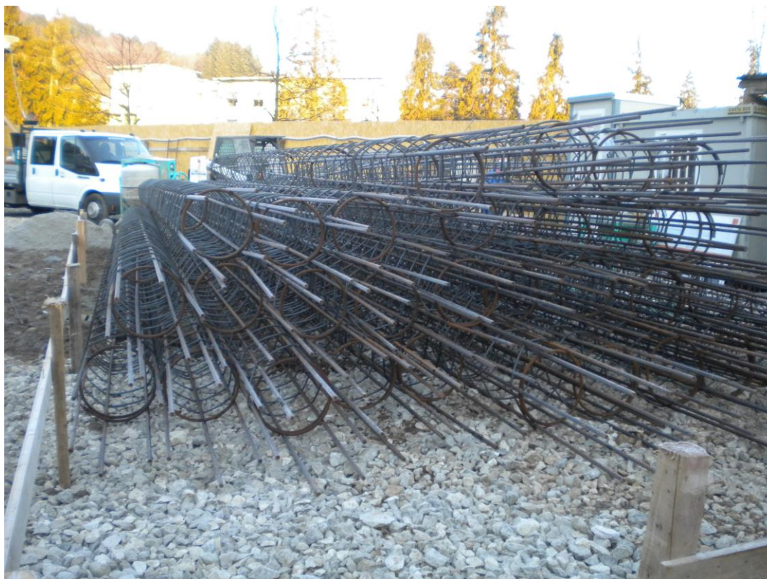
Fig.4.2a – Gabbie in cantiere pronte per la posa
