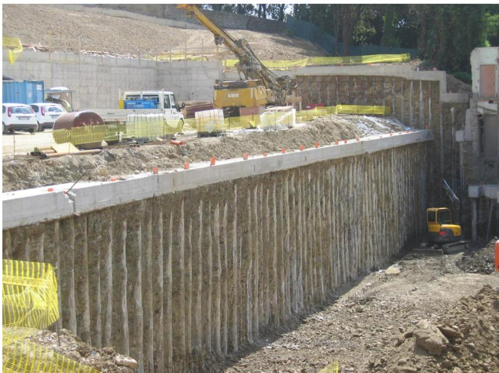
Fig.1.2 – Diaframma di micropali per il sostegno di un fronte di scavo
