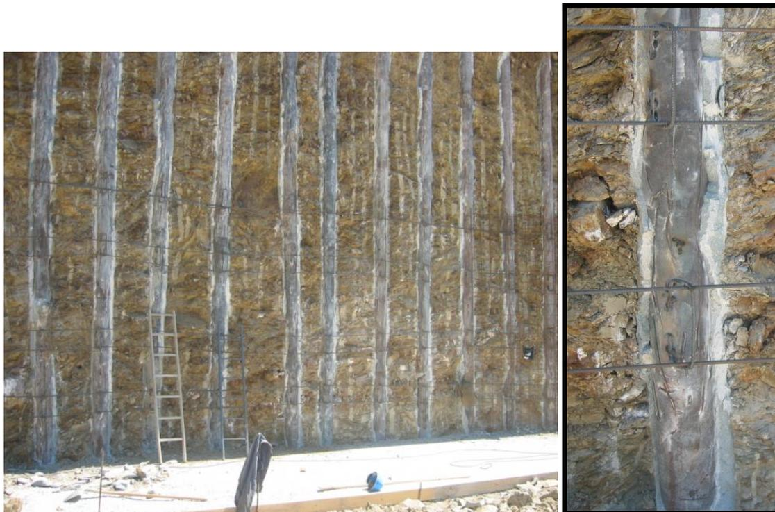
Fig.1.3 - geometria dei micropali e particolare del fusto e dell'armatura tubolare
