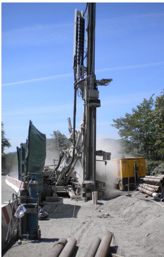
Fig.2.1 – perforazione a rotopercolazione
