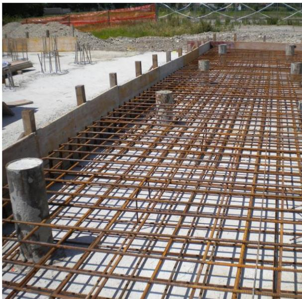
Fig.1.1 – Armatura di una platea su micropali
