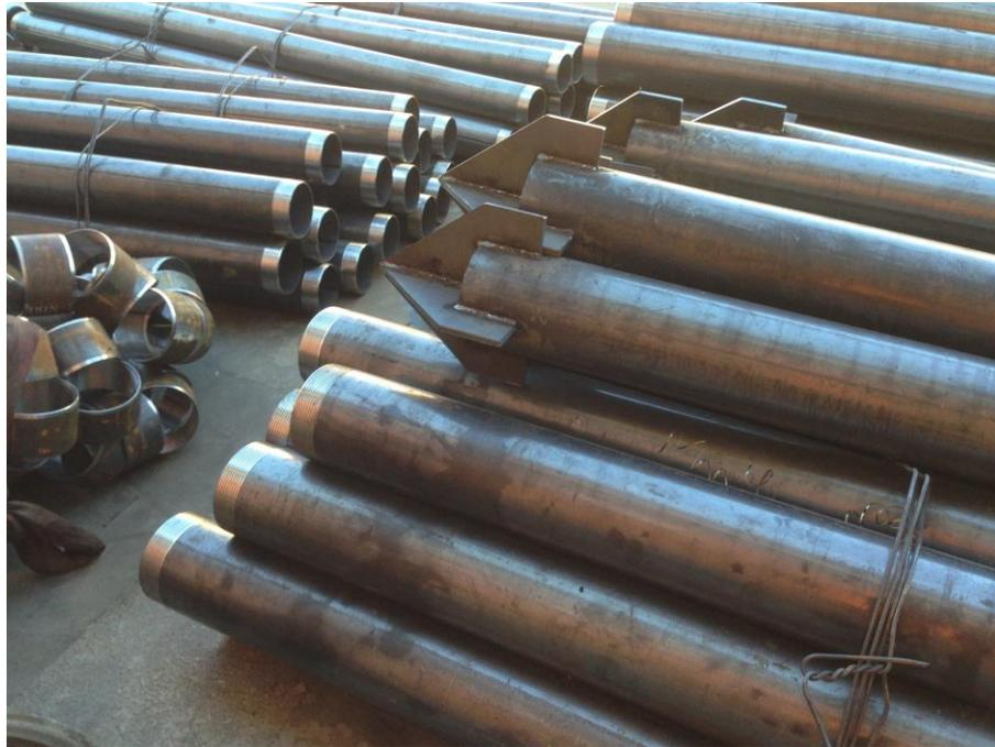
Fig.2.3 – armatura tubolare stoccata in cantiere dotata di punta quadri lama
