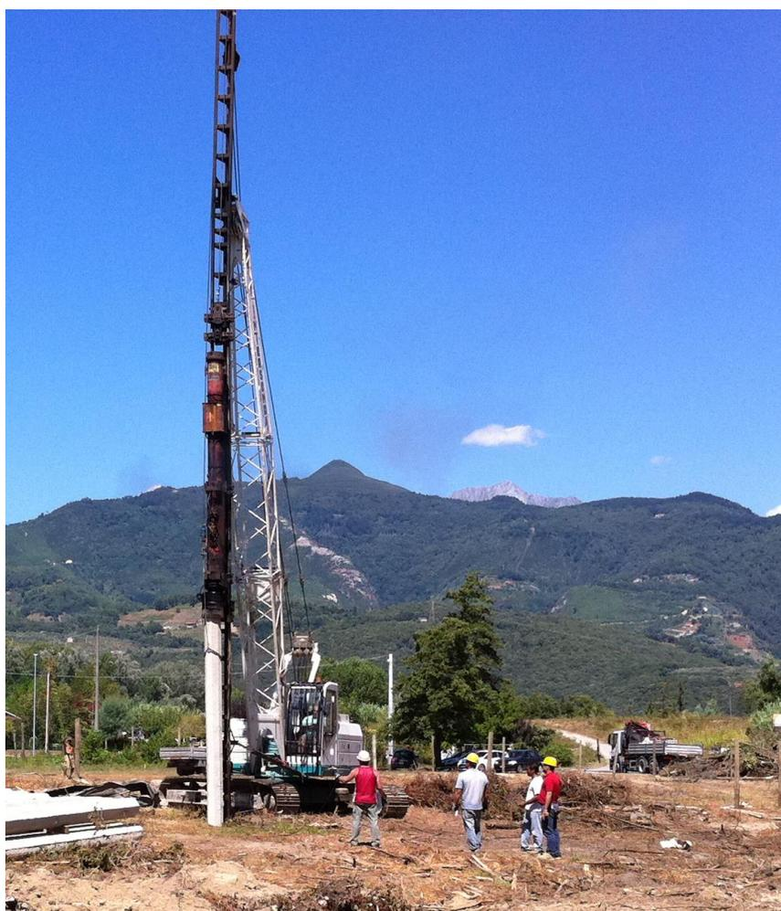
Fig.1.1 – infissione dei pali mediante maglio a percussione diesel
