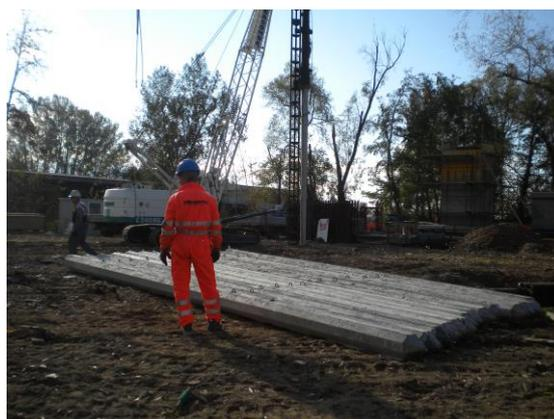
Fig.1.2 – stoccaggio dei pali in cantiere prima della battitura
