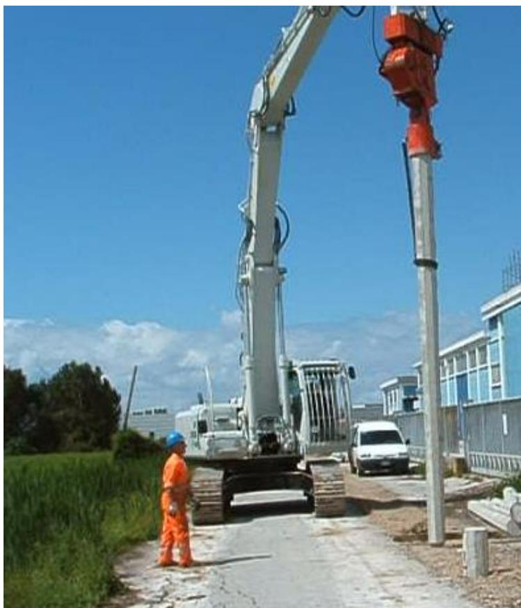
Fig.3.2 – Posizionamento del palo prima dell'infissione
