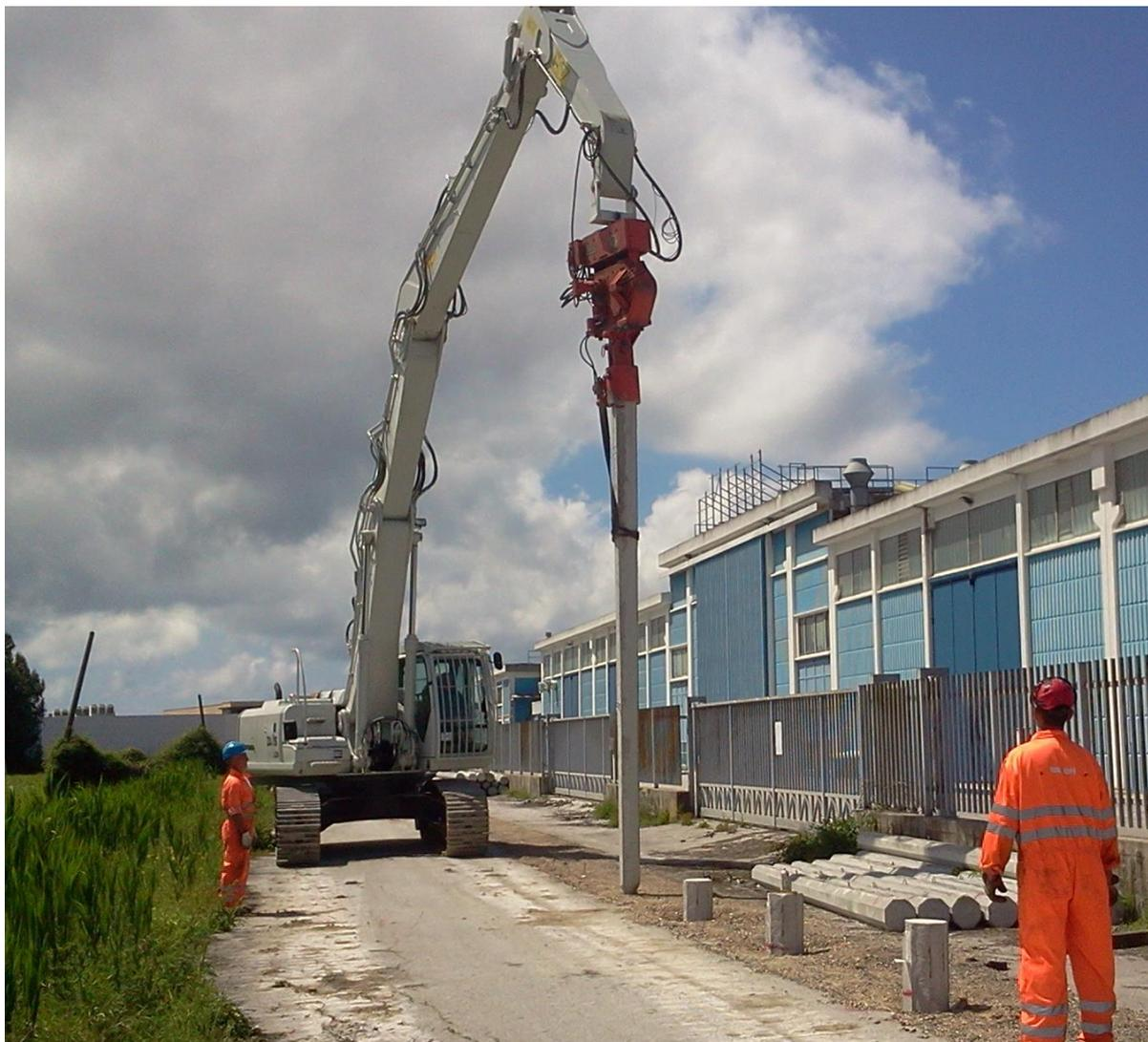
Fig.1.1 – infissione dei pali mediante vibroinfissore
