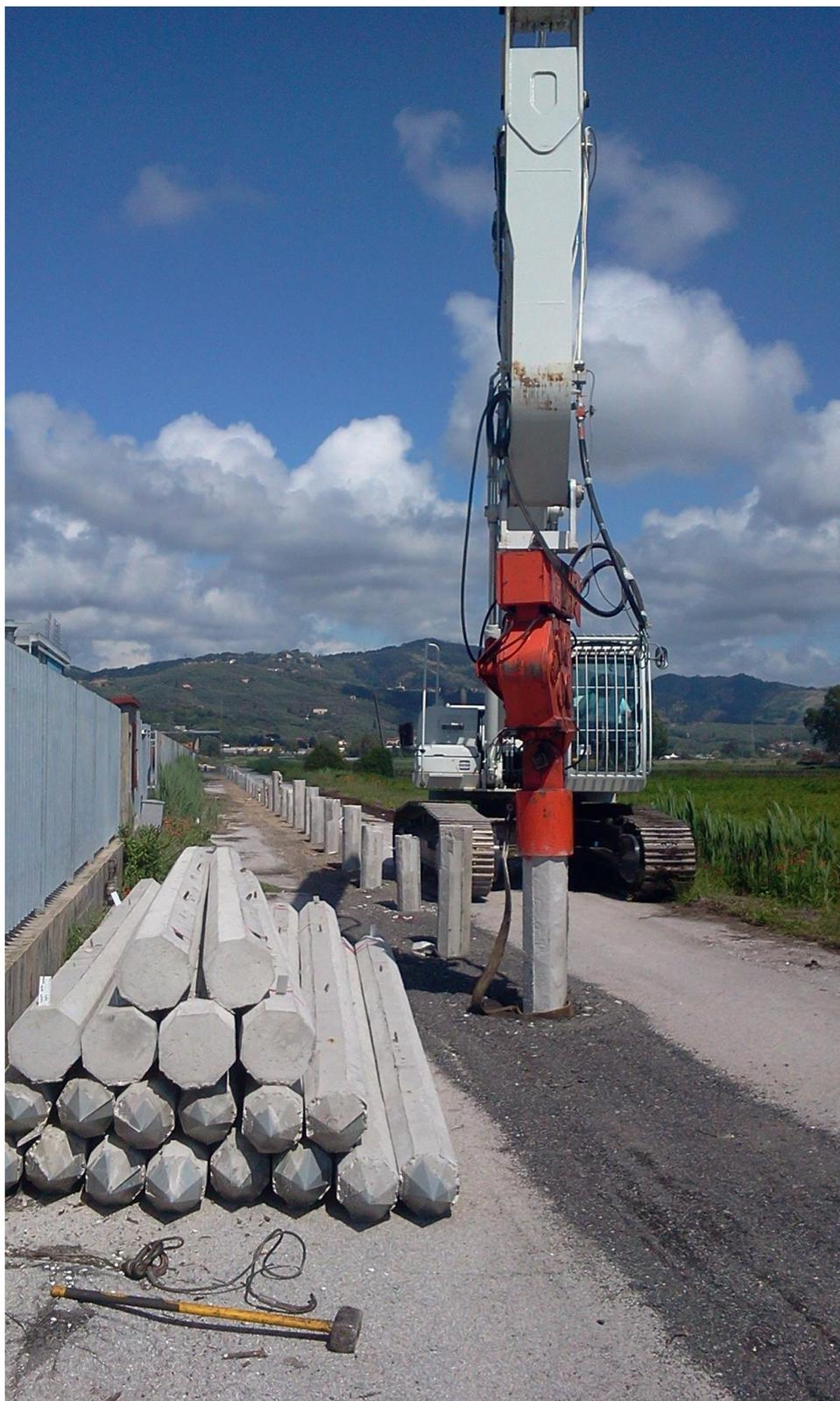
Fig.1.2 – stoccaggio dei pali in cantiere
