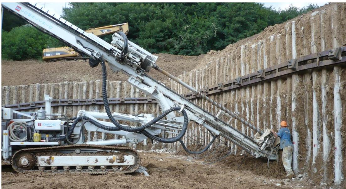
Fig.2.2 – perforazione ad elica
