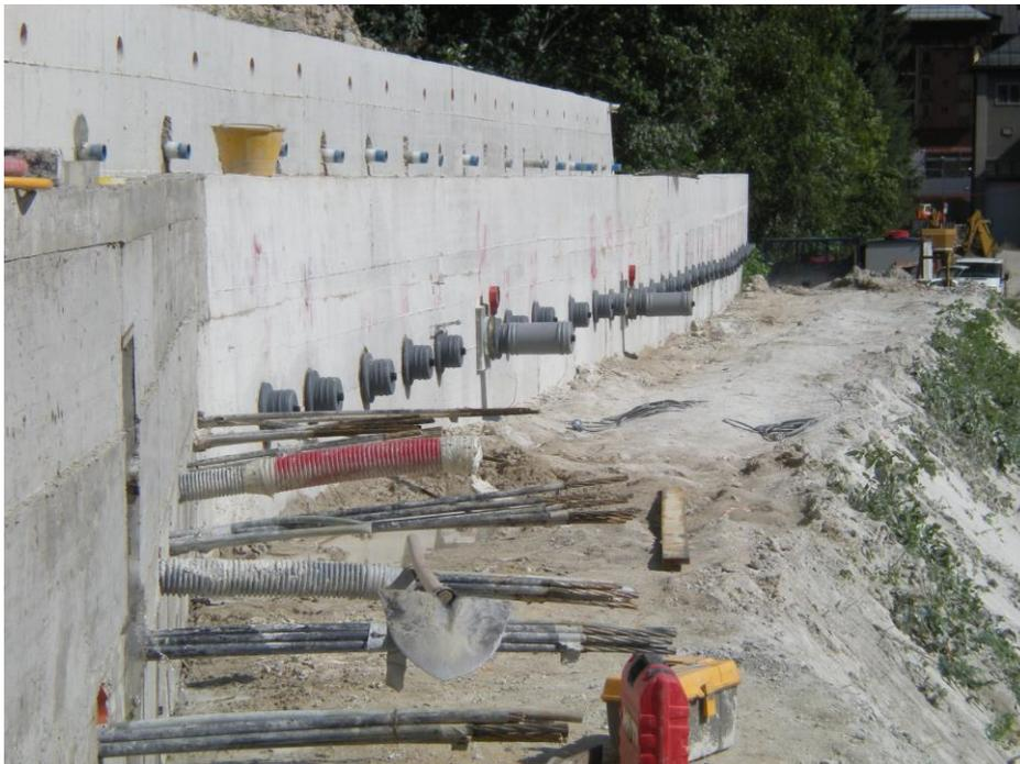
Fig.2.9 – protezione dei tiranti al termine del collaudo e della presollecitazione (sullo sfondo due tiranti predisposti con cella di pressione) CORDOLO IN CA TIRANTATO
