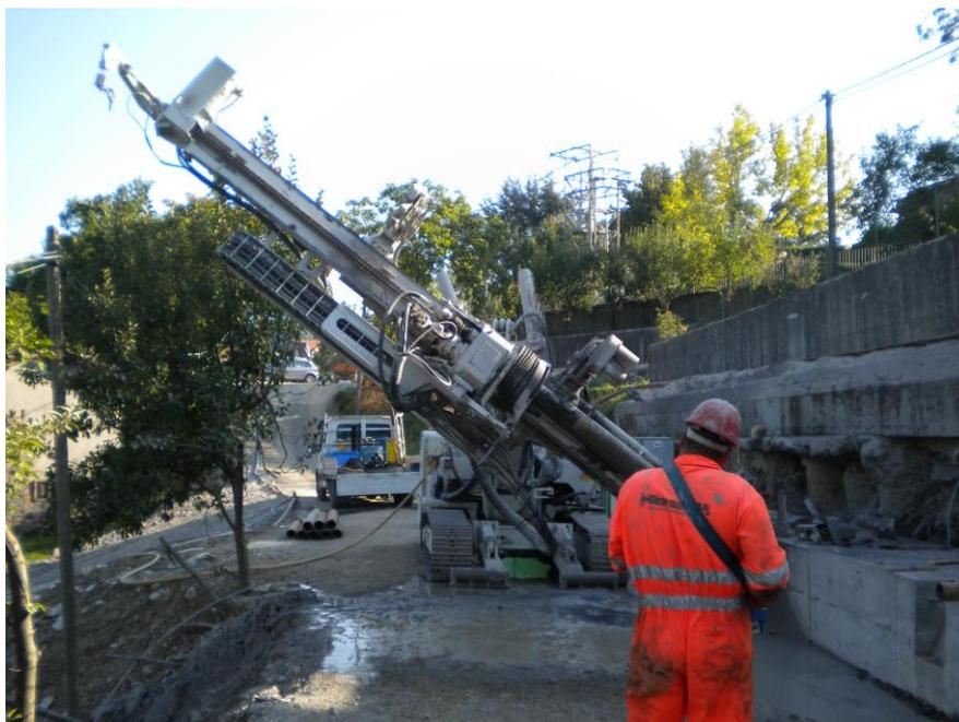
Fig.2.2 – perforazione a rotopercussione
