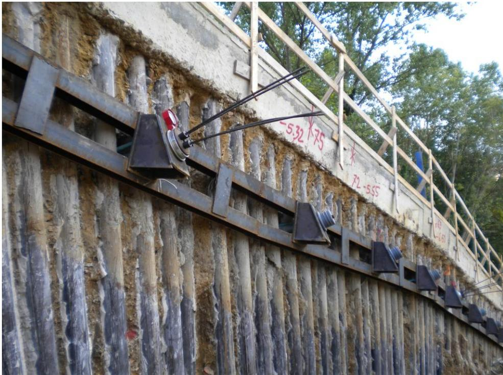
Fig.2.8 – protezione dei tiranti al termine del collaudo e della presollecitazione (in primo piano un tirante predisposto con cella di pressione) BERLINESE DI PALI
