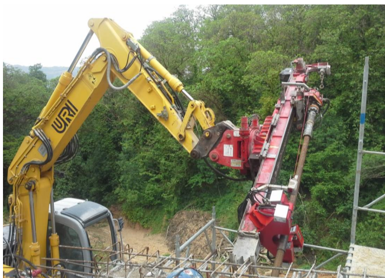
Fig.2.5 – Perforazione con antenna su escavatore
