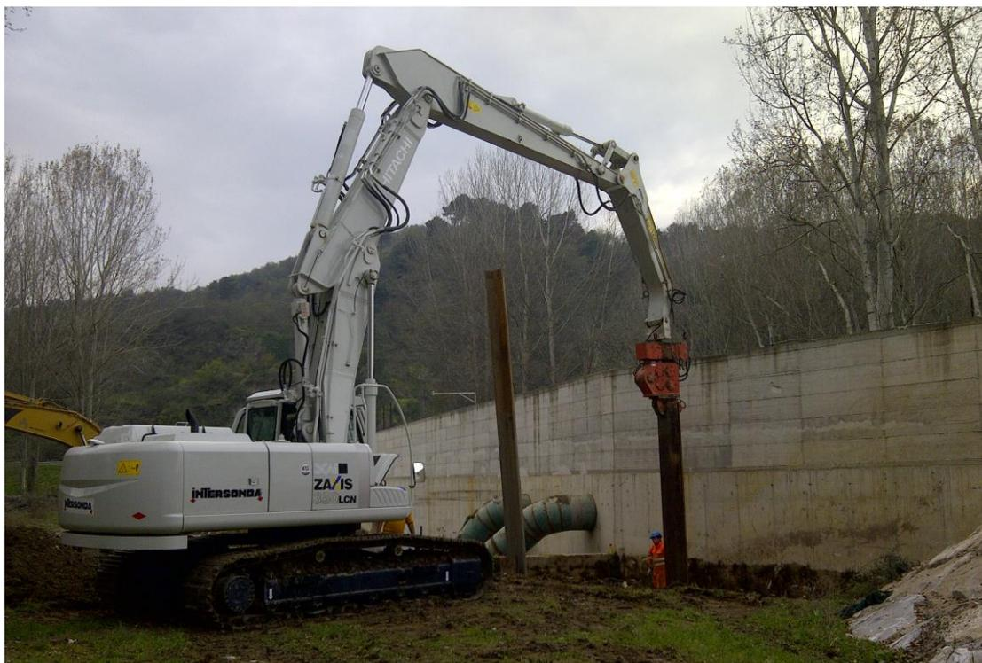
Fig.3.1b – Esempio di infissione tramite vibroinfissore montato su escavatore
