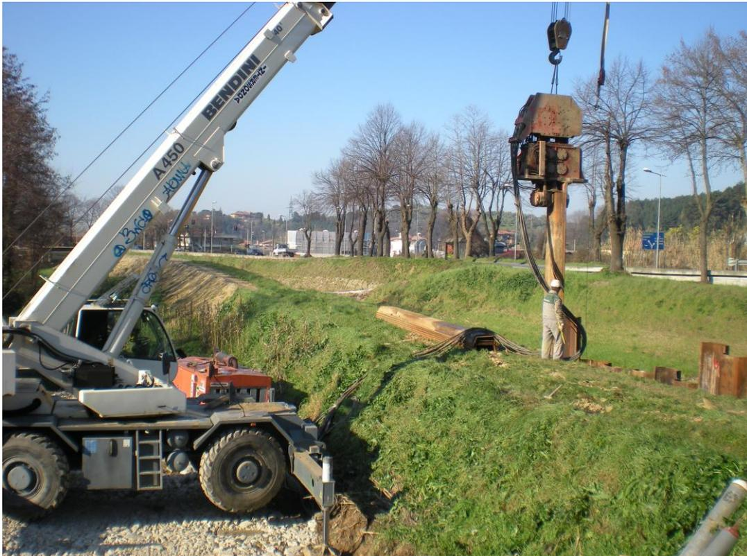
Fig.3.1a – Esempio di infissione tramite vibroinfissore centralina e gru gommata
