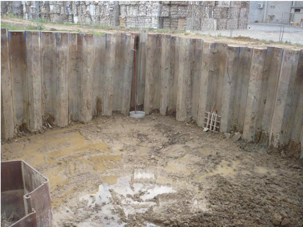
Fig.1.1 – Esempio di palancolato metallico provvisorio
