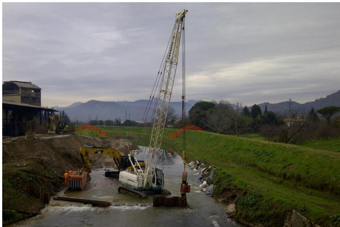
Fig.3.1c – Esempio di infissione tramite vibroinfissore centralina e gru cingolata
