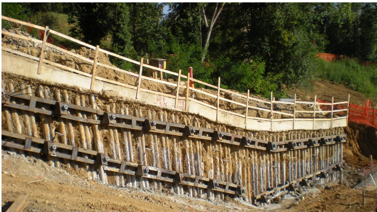
Fig.1.2 – canne drenanti tra due ordini di tiranti su di una berlinese di micropali
