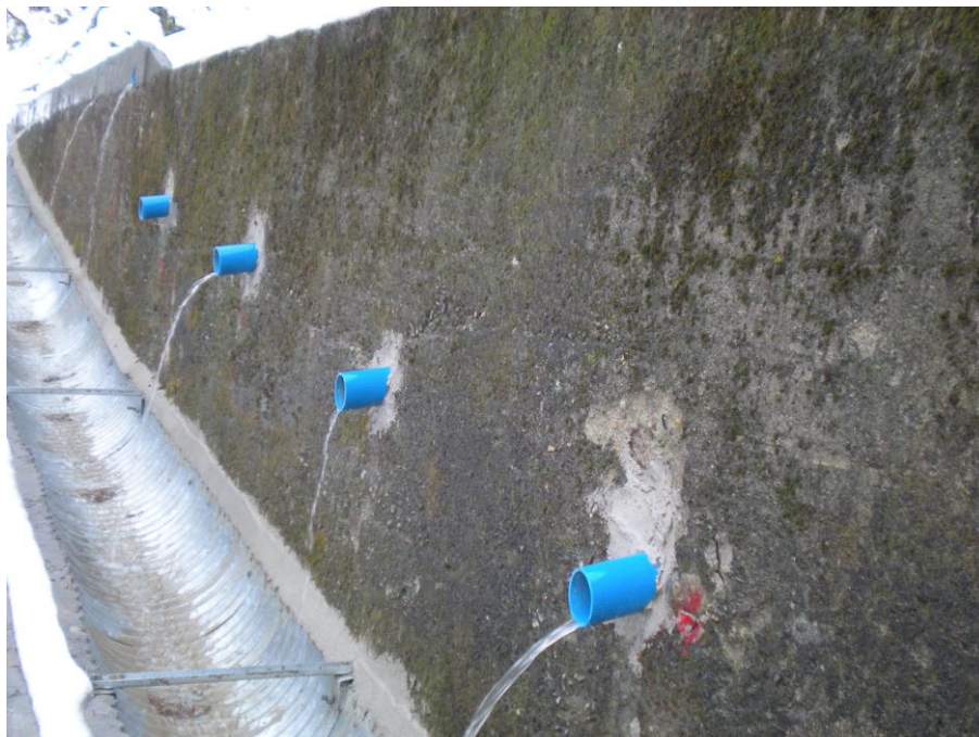
Fig.1.1 – canne drenanti in esercizio su opera in ca
