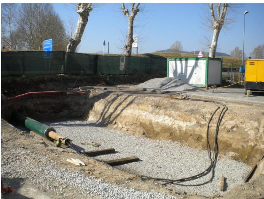
Fig.1.3a – Spingitubo allestito per l'infissione nella vasca di spinta con tubazioni collegate al compressore
