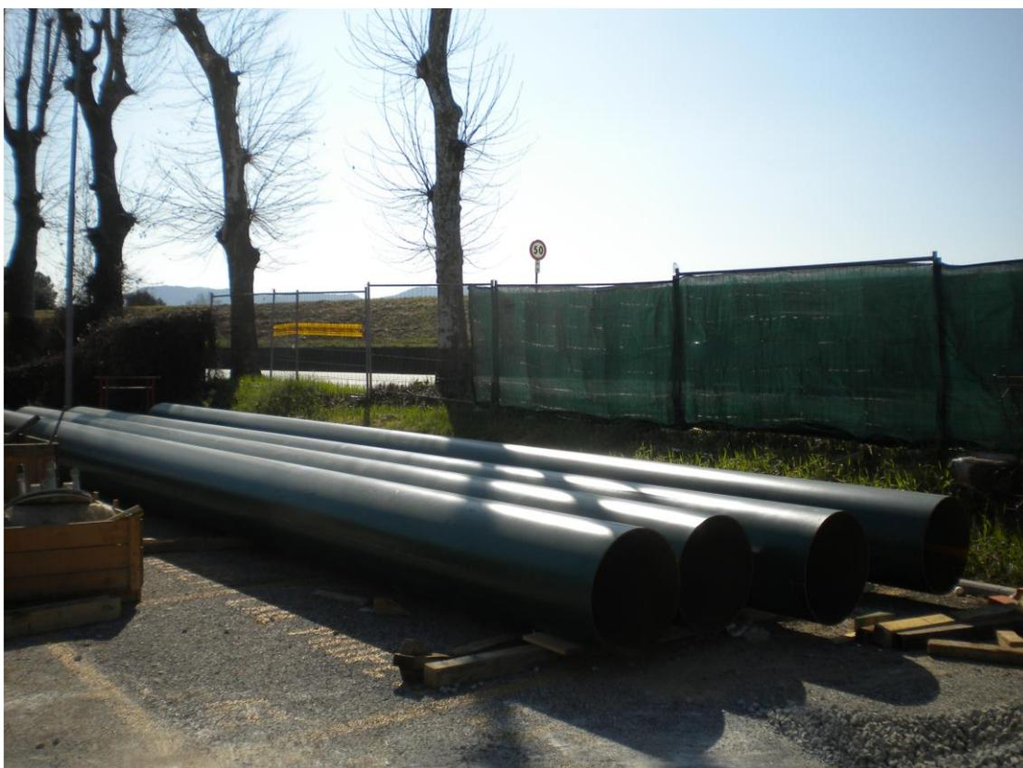
Fig.1.2a – tubi stoccati in cantiere prima della posa
