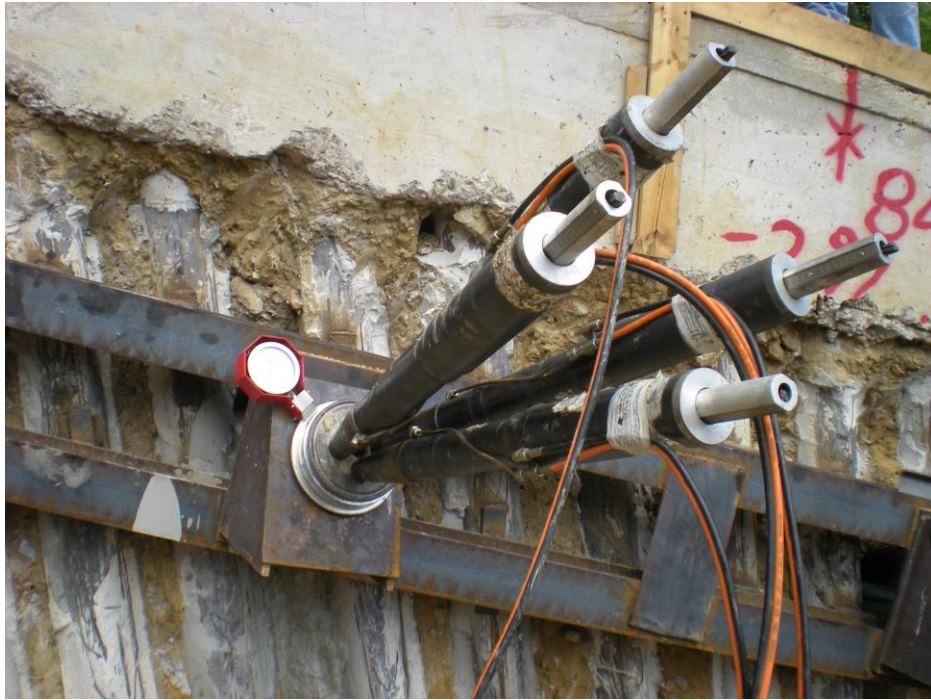
Fig. 1.3 – martinetti utilizzati per la tesatura dei tiranti a trefoli
