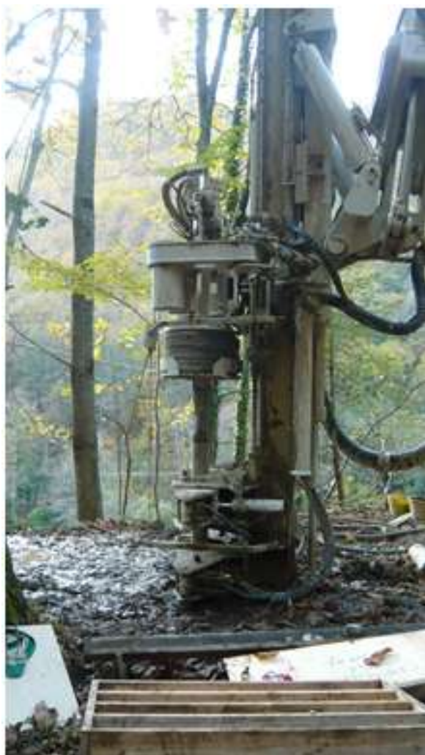
Fig.1.1 – perforatrice durante la realizzazione di un sondaggio
